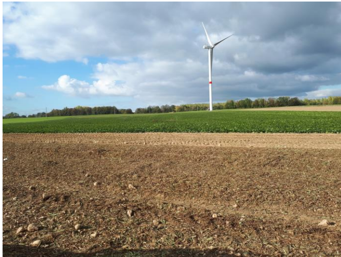
Fernelmont 2 : un parc éolien en zone agricole
