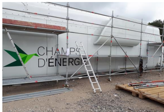
L'éolienne de Champs d'Énergie en cours de montage
